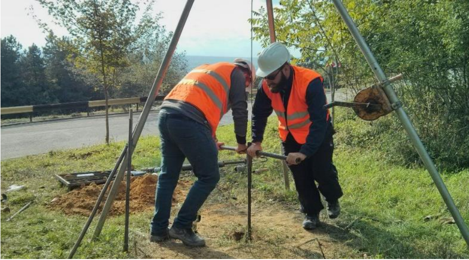
Fig. 7.17 Realizarea forajului BH1
