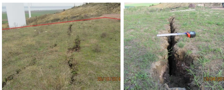
Fig. 8.3 Fisuri dezvoltate perpendicular direcției de alunecare
