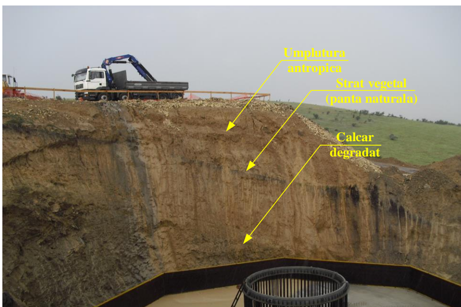
Fig. 8.1 Imagine care surprinde execuția platformei din umplutură necontrolată peste stratul de pământ vegetal
