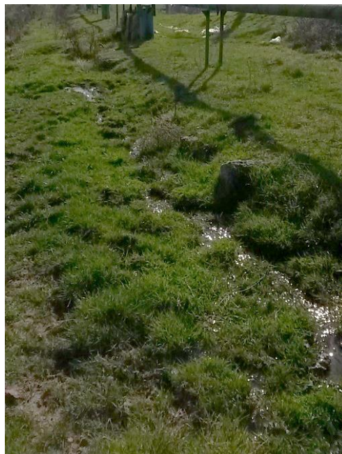
Fig. 7.15 Șiroi de apă care se scurge pe versant de la stația de tratare
