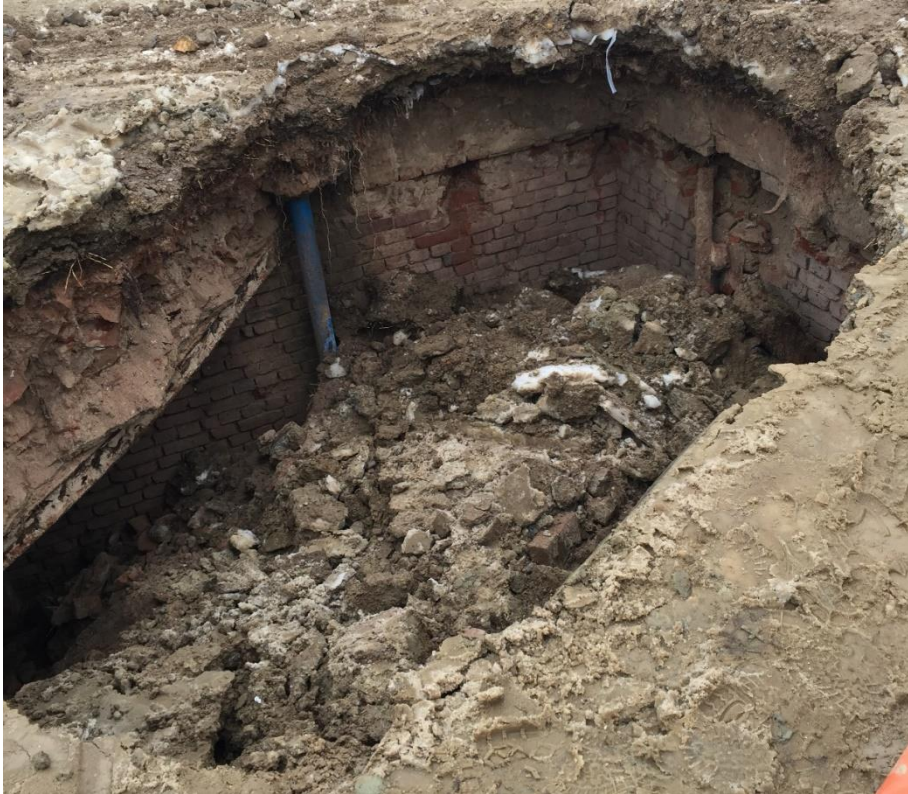
Fig. 5.10: Imagine a cavității reale, dezvelită în amplasament în urma identificării acesteia cu tehnica ERT
