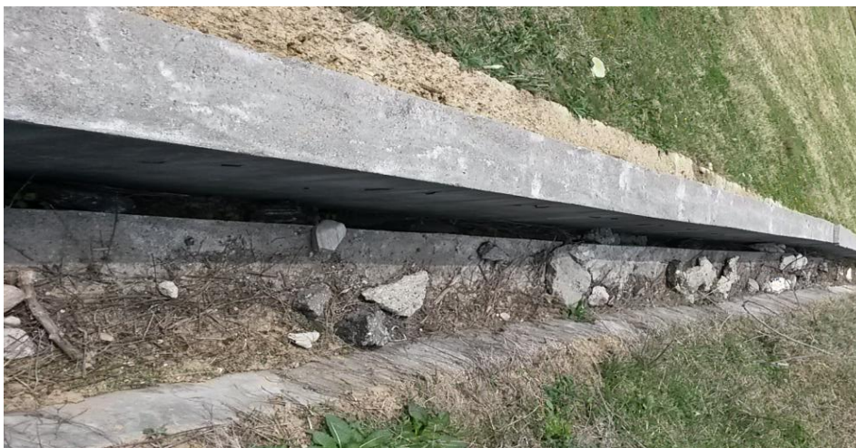
Fig. 7.10 Detaliu asupra zidului de sprijin și rigola din spatele acestuia
