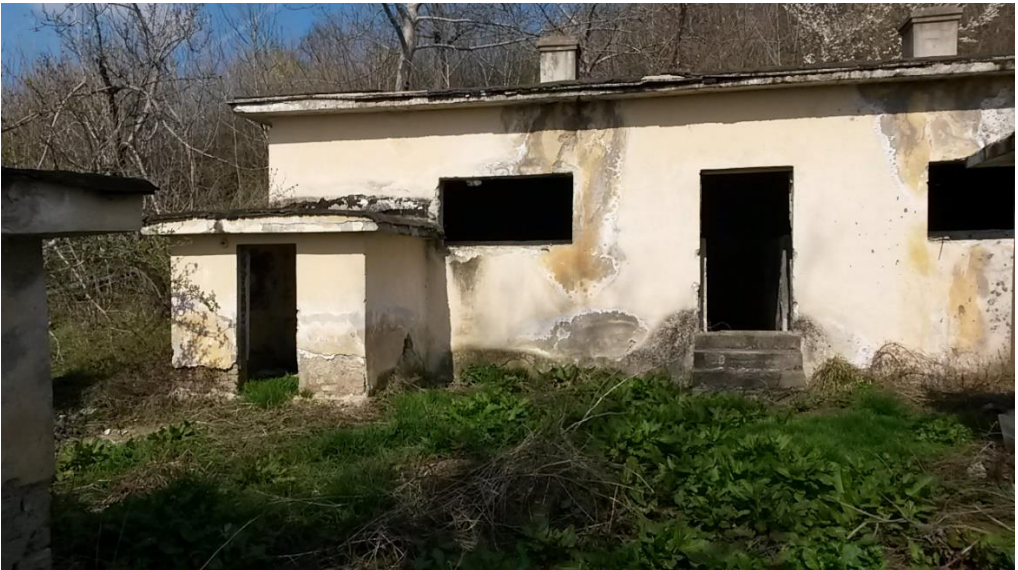
Fig. 7.14 Stația de tratare
