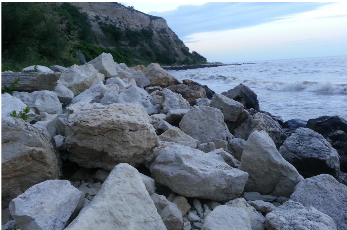
Fig. VI.173: Protecție de coastă cu anrocamente (Albena, Bulgaria)
