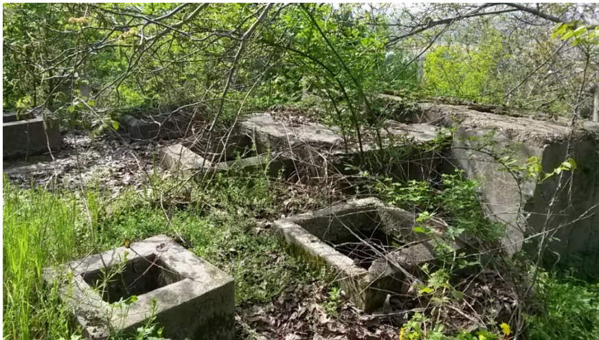
Fig. 5.37: Bazin de colectare al apelor uzate (volum aproximativ 300 mc)
