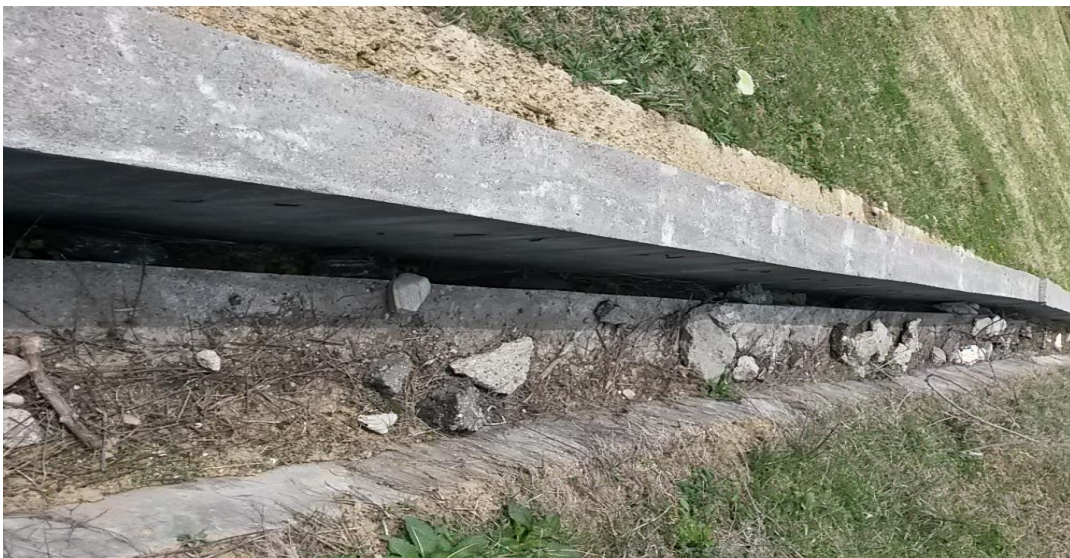
Fig. 5.35: Detaliu asupra zidului de sprijin și rigola din spatele acestuia
