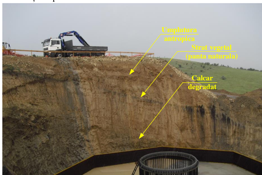
Fig. 5.60: Execuția platformei din umplutură necontrolată peste stratul de pământ vegetal
