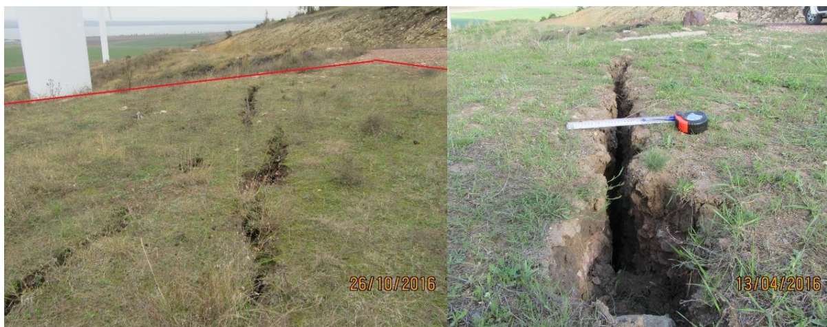
Fig. 5.62: Crăpături dezvoltate perpendicular direcției de alunecare
