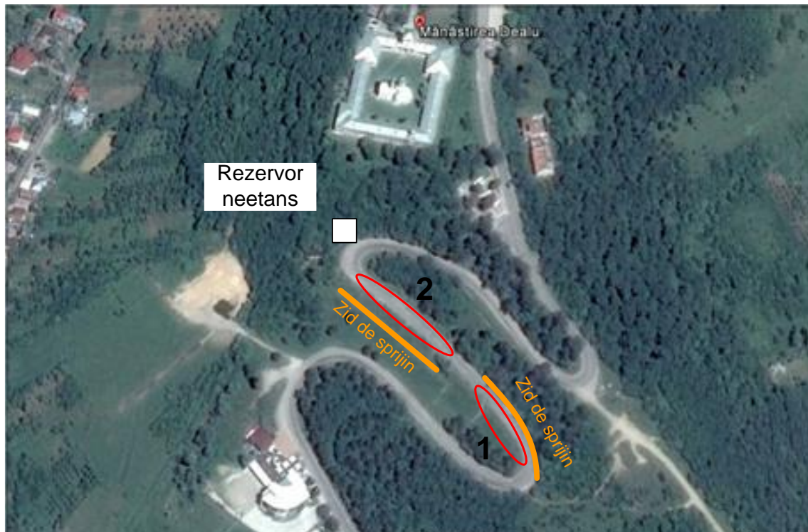
Fig. 5.30: Porțiuni ale drumului afectate de alunecări de teren
