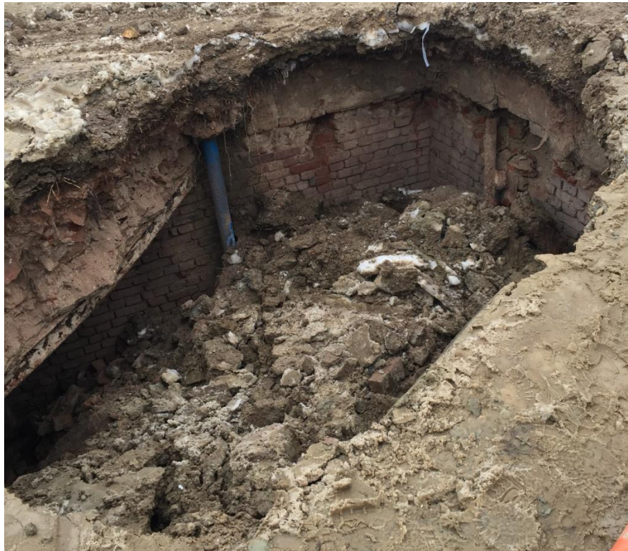
Fig. 5.10: Cavitate reală dezvelită în amplasament
