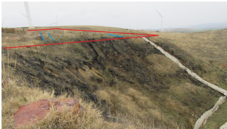
Fig. 5.61: Vedere laterală a platformei (linia roșie - limita platformei; liniile albastre – crăpături la suprafață)
